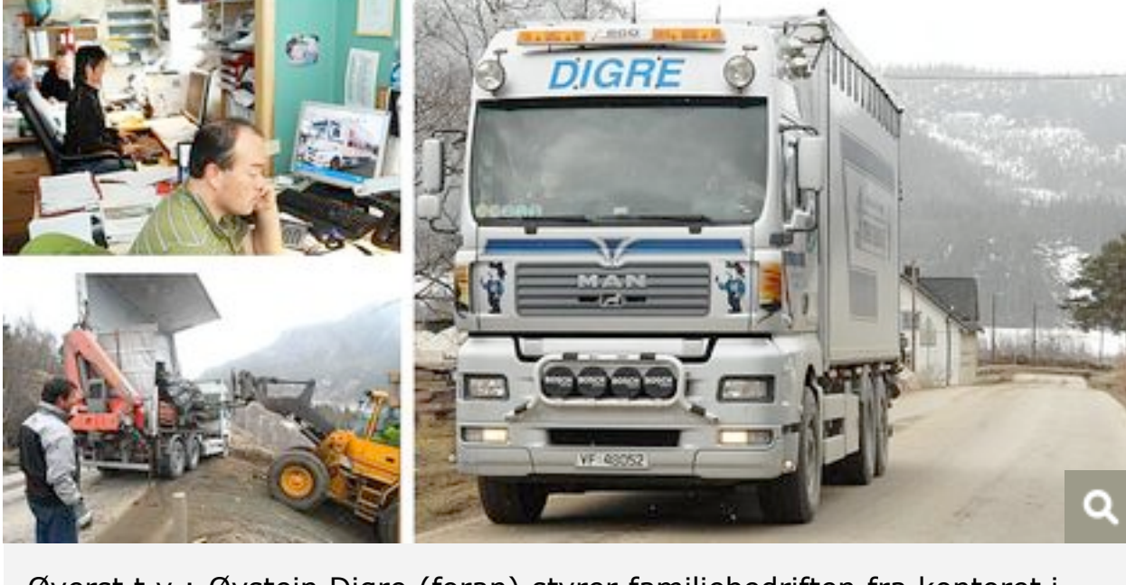
Øverst t.v.: Øystein Digre (foran) styrer familiebedriften fra kontoret i Singsås sammen med søster Solveig, far Ingmund (bak til venstre), og Erling Kjerstad. Ned til venstre: Hans Digre følger med når sprengningsmatter til veiarbeidet til utbedringen av riksvei 30 ved Fjesebakken og Osøy bur blir losset fra lastebilen. FOTO: KJELL A. OLSEN
